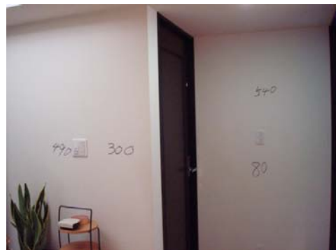
玄関・廊下 壁面
